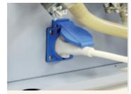
Enchufe para la conexión y mando de la bomba de aire
